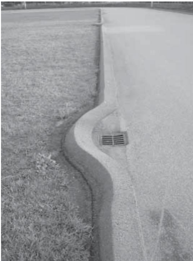
Voorbeeld straatkolken buiten ideale lijn combinatiebaan LCB A te Ede.
